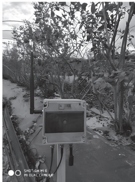
Figura 20. Dispositivo instalado para monitoreo de sistema de riego con tecnología LPWAN
