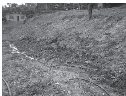
Figura 2. Erosión por mal manejo de tuberías
