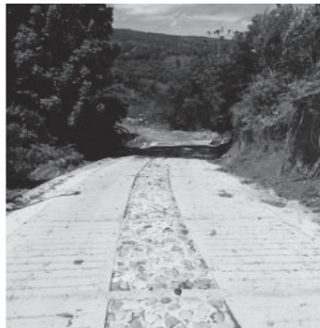
Figura 5. Construcción de placa huella en el municipio de El Tarra, Norte de Santander
