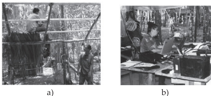
Figura 5. a) Construcción del techo de una vivienda con troncos de árboles y hoja de palma, b) oficinas y centro de operaciones
