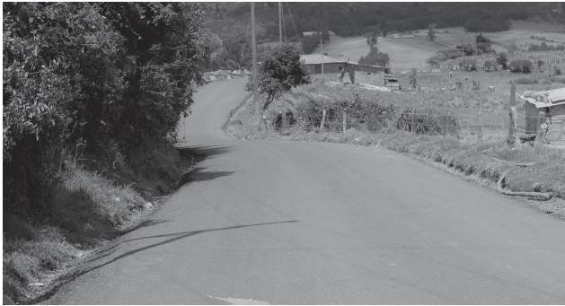
Figura 15. Vía rural de Bogotá D. C., localidad de Sumapaz, construida con carpeta asfáltica con 100 % del reciclado de pavimento flexible
