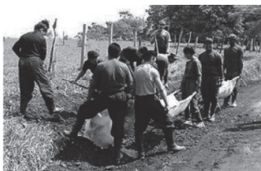
Figura 9. a) Construcción de drenajes laterales de la vía, b) utilización de equipos pesados para la construcción de vías, generalmente secuestrados de las obras oficiales aledañas
